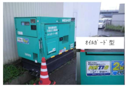
環境配慮型発電機の使用により 油流出防止の実施
