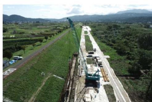
木島護岸工事
